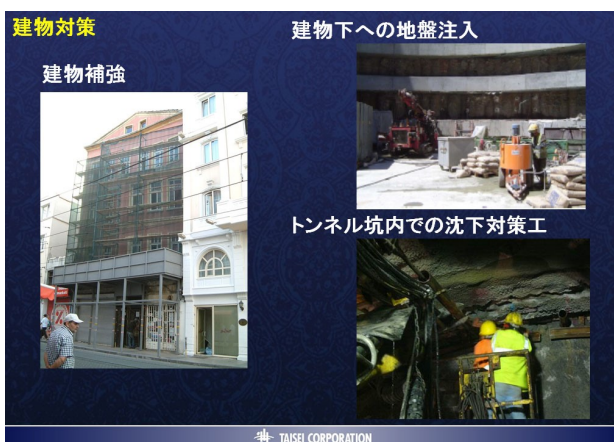
図-12 脆弱な建物への沈下対策
