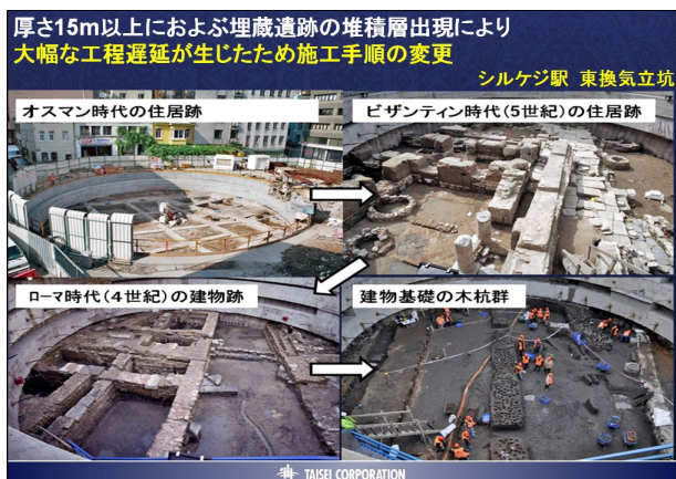
図-13 東換気立坑での埋蔵遺跡により工事中断
