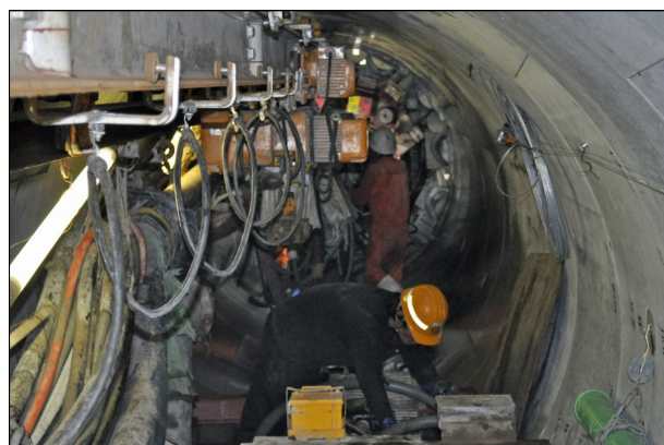
写真-4 切羽付近（小石原川ダム導水路トンネル）
