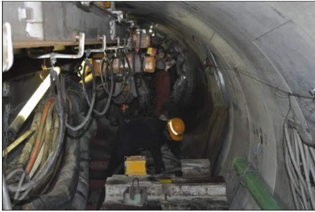
写真-2 放流工側坑口から2,010m地点の掘削現場
