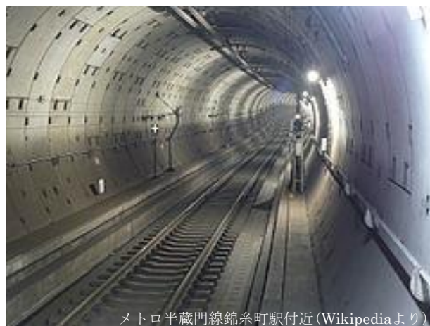
写真-2 セグメントで作られたトンネル
