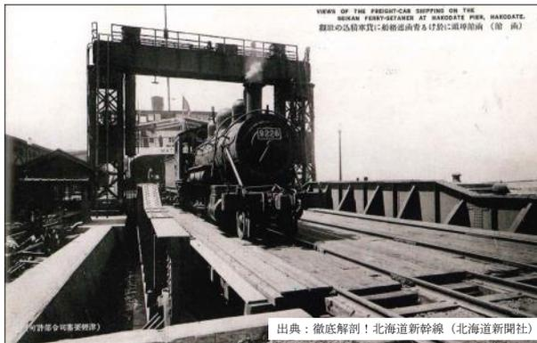
写真-10 青函連絡船に貨車を出入りさせる作業
