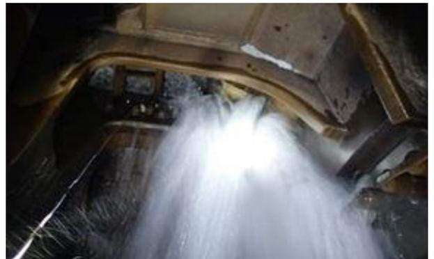
写真-3 突発湧水 (TBM-1)
