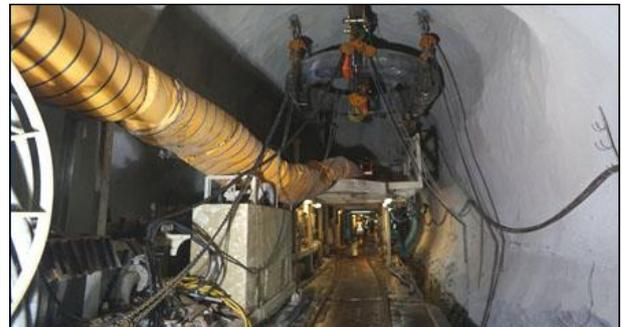
写真-5 新メインベアリングを拡幅部に収納
