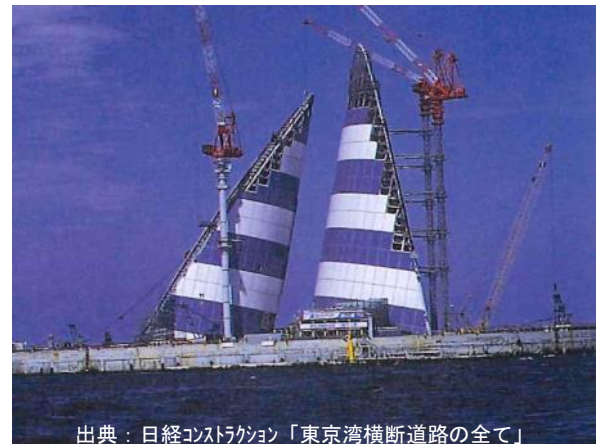
写真-1 建設中の川崎人工島(風の塔)
