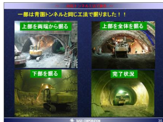
図-19 一部は山岳工法で掘削した
