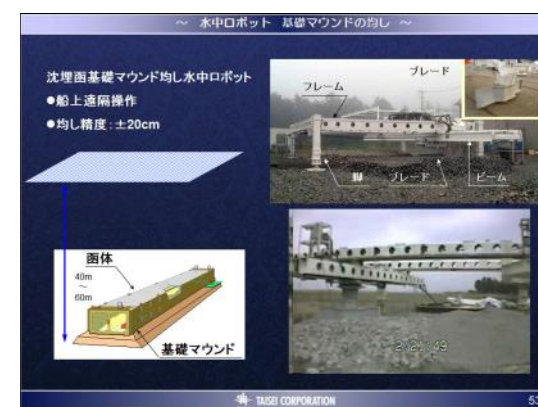
図-11 水中ロボットによる基礎マウント均し
