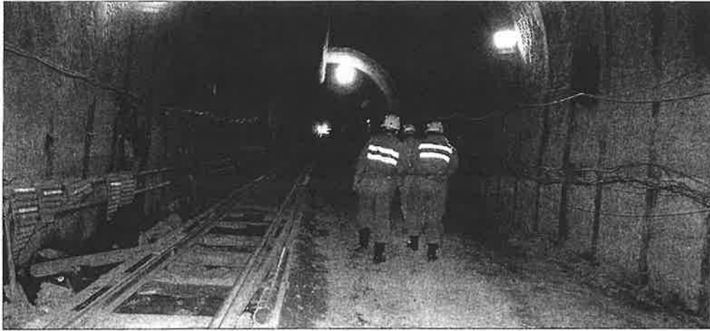
한·일해저터널 일본 측 시발지로 시험굴착작업이 진행됐던 일본 사가현 가라쓰 해저막장 전경. 부산일보DB
