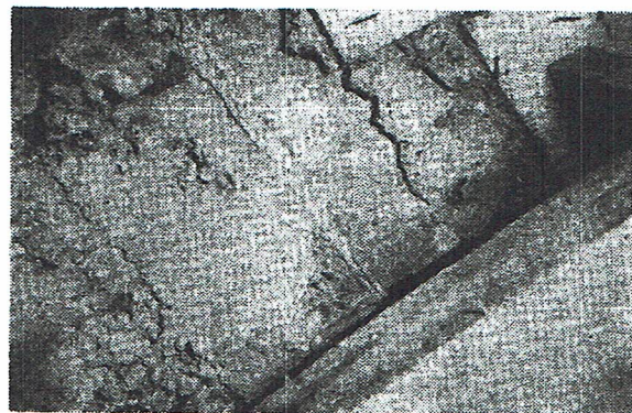
写真-5 圧縮された可縮目地
