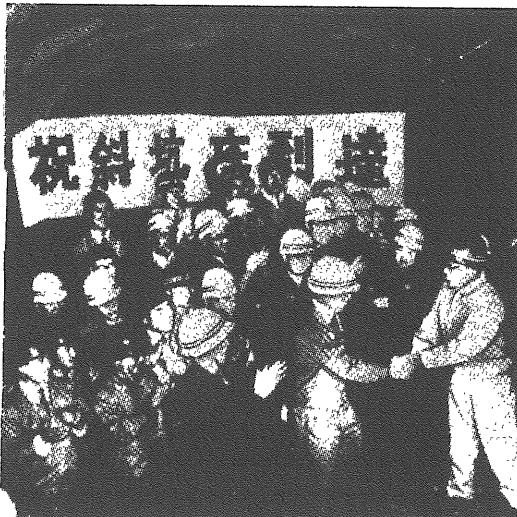
斜坑底到達(1967年)(津軽海峡 青函トンネルの歩み：福島町より)
