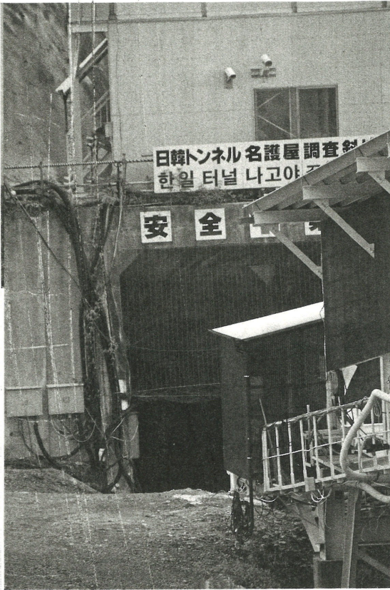
日韓トンネル名護屋調査斜坑。 上部に二基のカメラが見える
