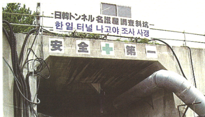
한·일터널 추진위원회가 기술요원들과 답사를 다녀온 가라쓰의 해저지질 조사용 터널. photo 한일터널 추진위
