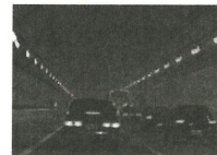
東京湾横断道路トンネル内部
