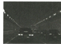
東京湾横断道路トンネル内部
