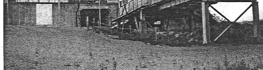
일본 히가시마쓰우라 반도 가라쓰의 한일 해저터널 굴착공사 현장. 현재 해저 400m까지 굴착한 상태다.
