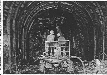
トンネル内部の様子
