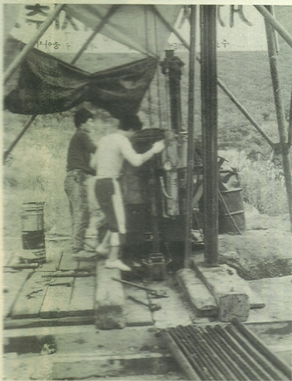
三巨里のボーリングは一日13mの速さで進んだ
