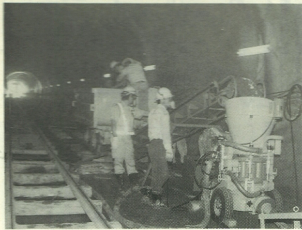
吹付け機械にコンクリートを補充する
