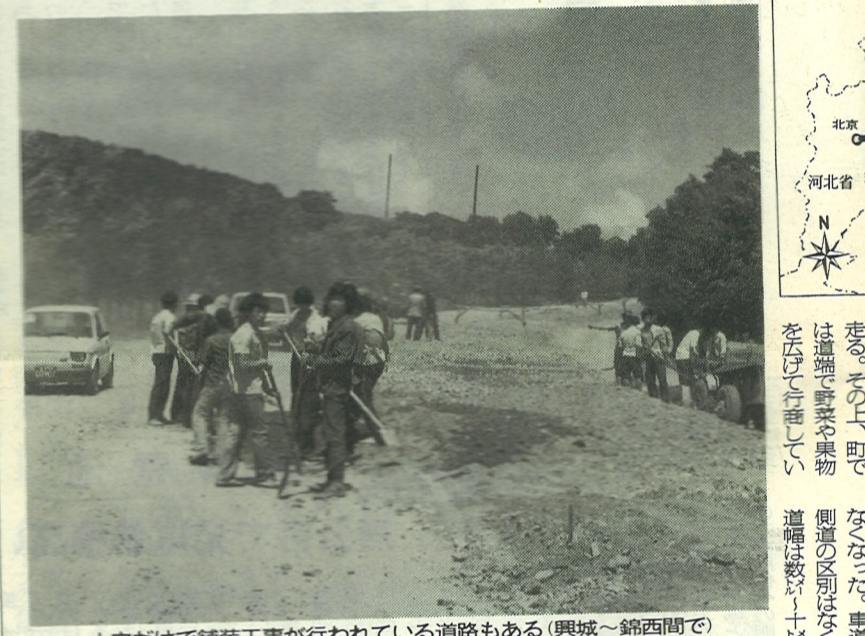
人力だけで舗装工事が行われている道路もある(興城~錦西間で)
