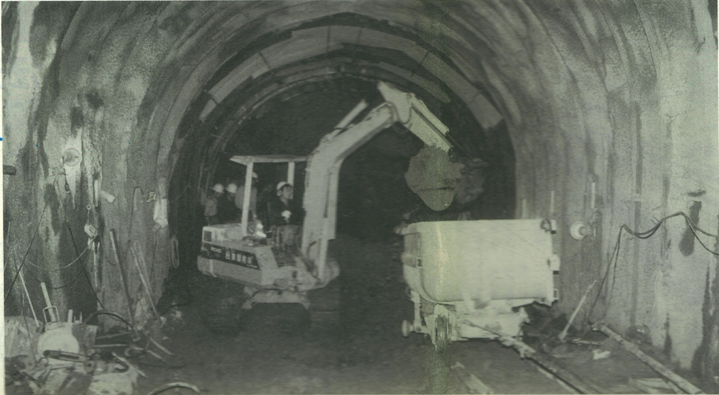
日韓トンネル調査斜坑は、九月一日から二期工事が始まった
