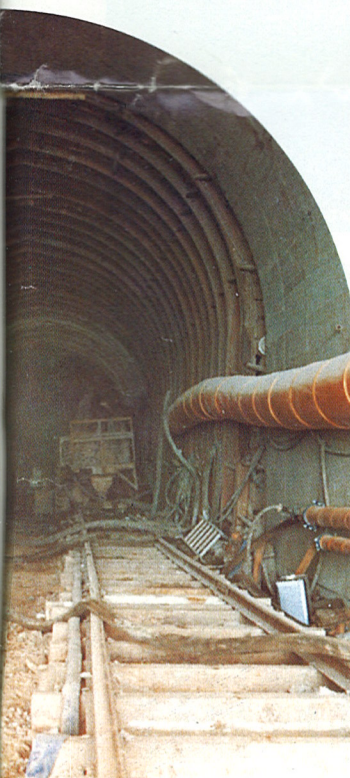
高さ5.5mの調査斜坑は、(株)熊谷組・共同企業体によって掘削中。3月末掘り進められている。
