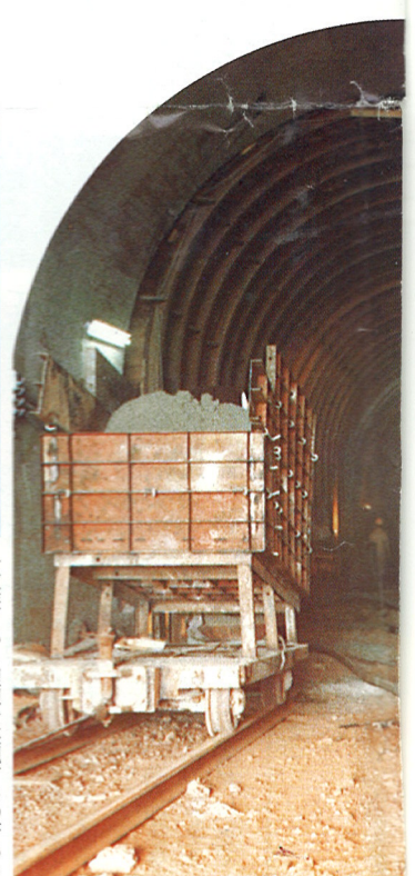
調査斜坑の掘削 幅6m、三井建設機で180mほど
