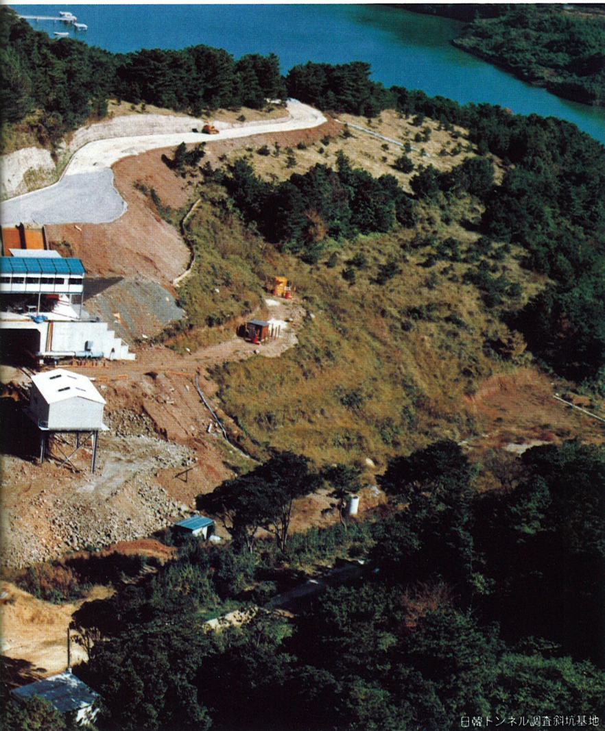
日韓トンネル調査斜坑基地
