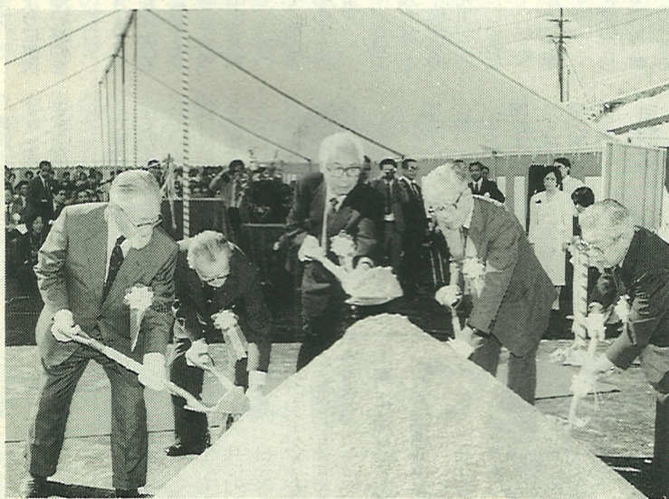
工事の無事を祈ってくわ入れが行われた(くわ入れする研究会役員)
