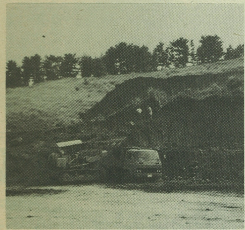
斜坑予定地では造成工事が急ピッチで進められた
