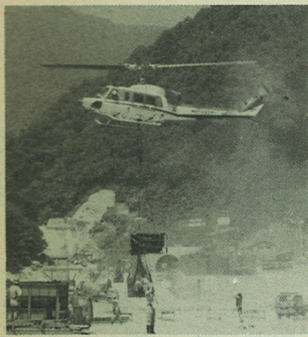
ヘリコプターによる立坑への資材運搬
