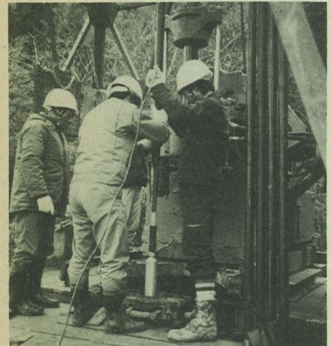
▲地震計センサー挿入状況
