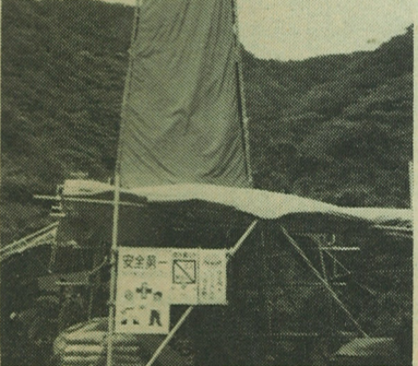
▲対馬陸上部ボーリング状況
