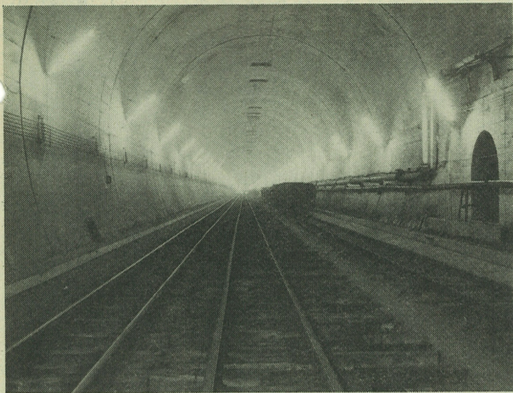
▲完成した本坑内部
