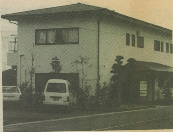
新装なった唐津事務所
