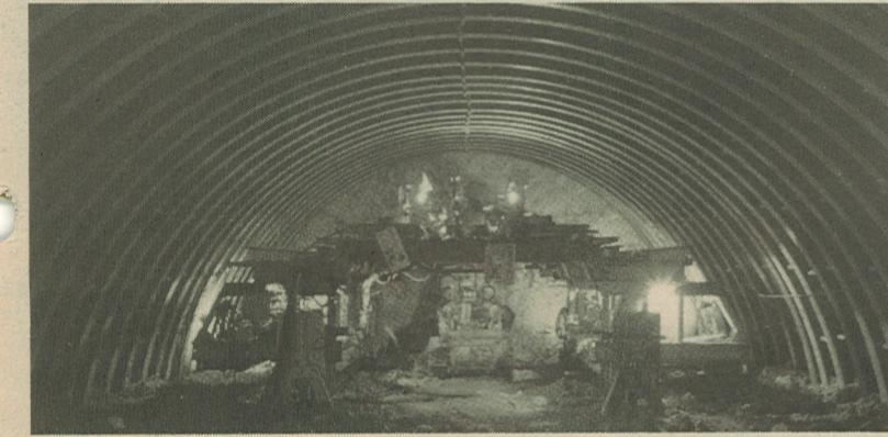
青函トンネル本坑上半部の施工状況
