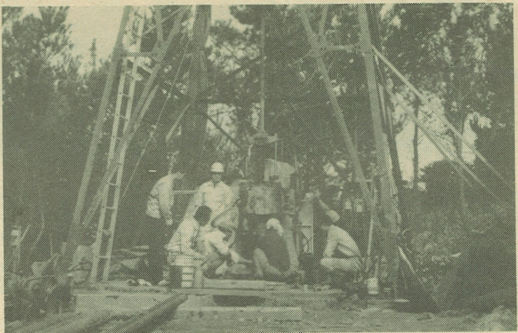
深層ボーリング調査
