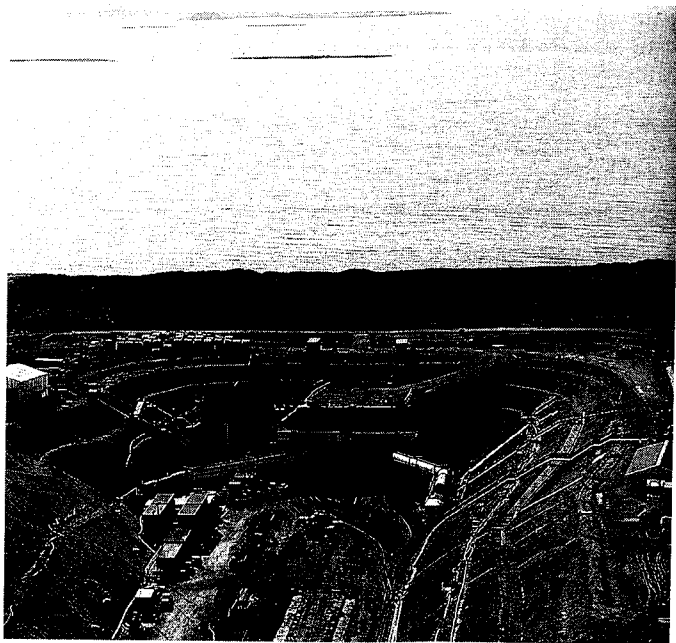
首都コペンハーゲンのあるシェラン島からスプロー島へ向かう海底トンネルの入口工事現場
