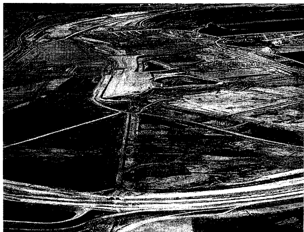
図20 フランス側のコクウェル・ターミナルの工事前(上)と工事中(1990)の風景
