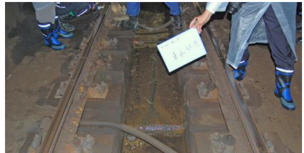
写真-3 豆トンネル内の溝を流れる湧水
