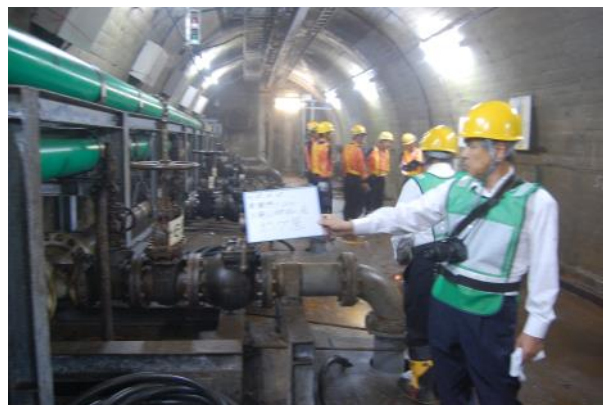
写真-4 火の山斜坑底のポンプ室
