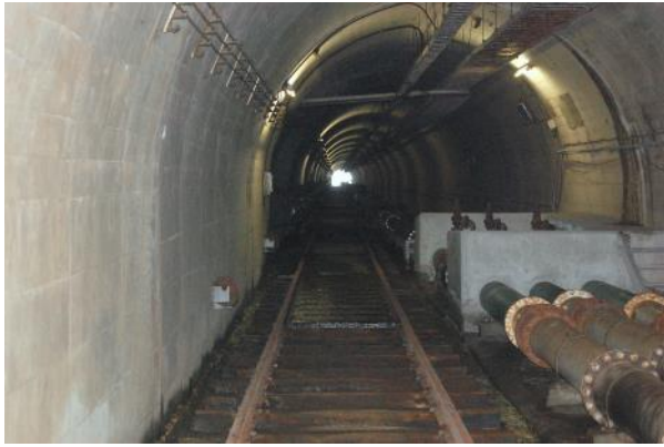
写真-5 火の山斜坑に設置された3本の排水管
