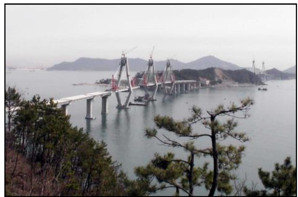
コガ(巨加)大橋の建設現場
