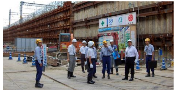
新博多駅ビルの工事現場視察
