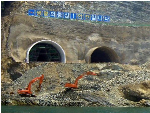
チュンジュック島に建設されたトンネルの坑口
