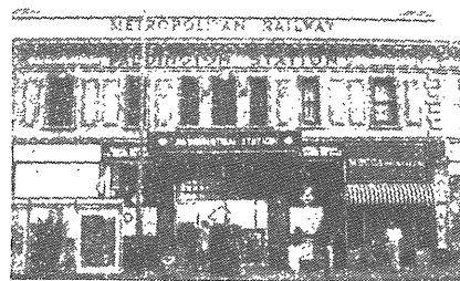
(b)地下鉄駅
