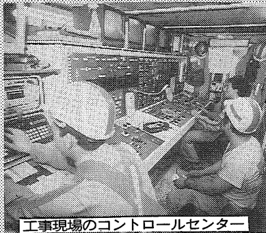
工事現場のコントロールセンター
