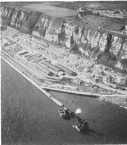
イギリス側の掘削現場があるドーバー
