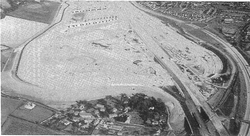
フランス側の掘削現場があるカレー
